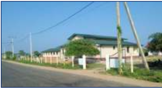
OPD Building DH - Sampoor, Trincomalee TCE : 26 mn Source of Fund : PSDG
